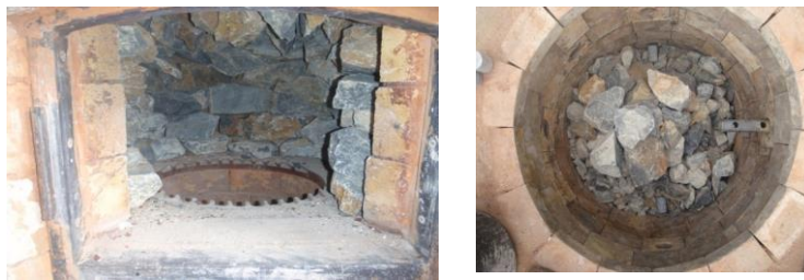
Obr. 3 ukázka klenebního prostoru vyskládaného z vápence – tradiční vytvoření prostoru ohniště.
