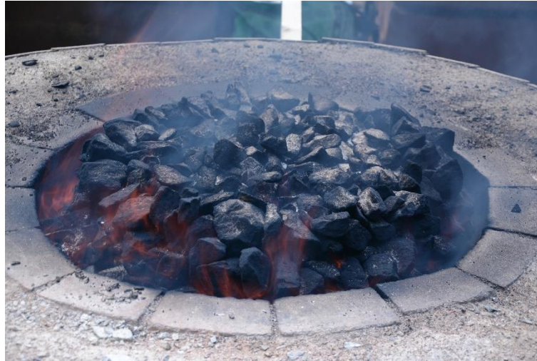
Obrázek 2. Horní část pece se skládanými menšími kameny a před zakrytím jílovo-slámovou mazaninou.
