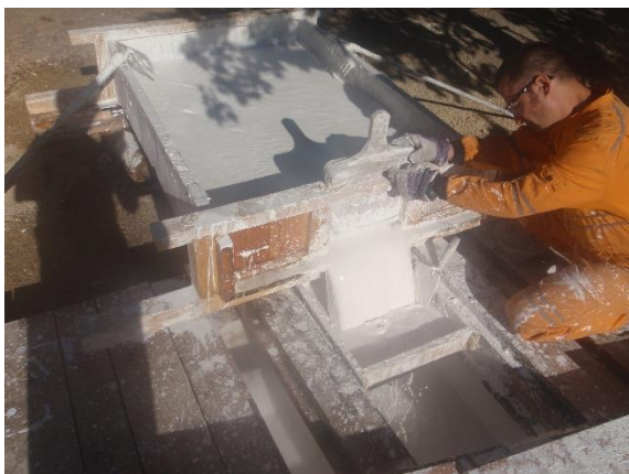
Obrázek 1 – 5. Přepuštění vápenného mléka do jámy.
